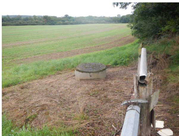
Regard en béton sur le haut de talus coté val en amont du tronçon n°2 (vu vers l'aval)
