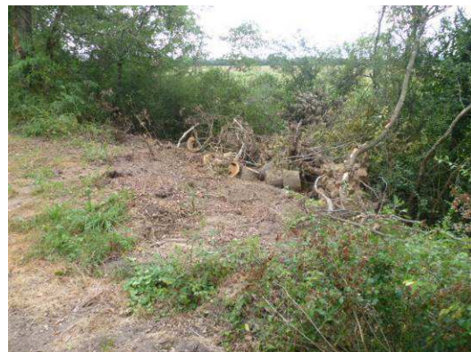
Figure 4 : travaux après tempête de juin 2012 sur haut du talus coté val (vue vers l'amont - source DDT58)
