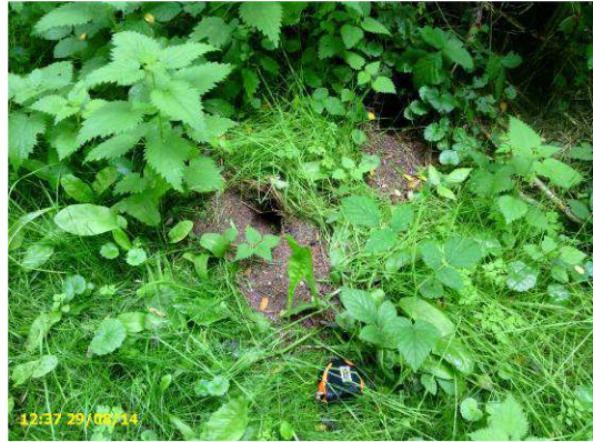
Terrier 5cm diamètre – talus val sur tronçon n°2
