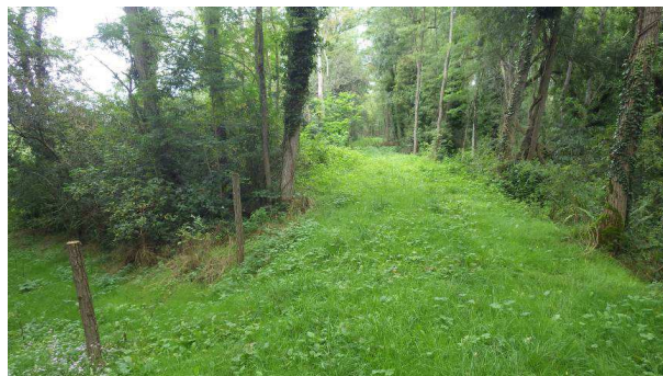
Figure 16 : vue de la crête de la digue enherbée en aval du tronçon n°2 (photo prise vers l'aval)
