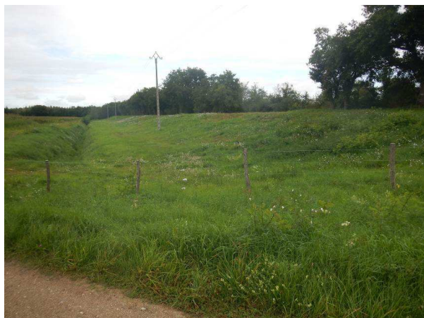
Vue vers l'aval des 3 pylônes en pied de talus coté val
