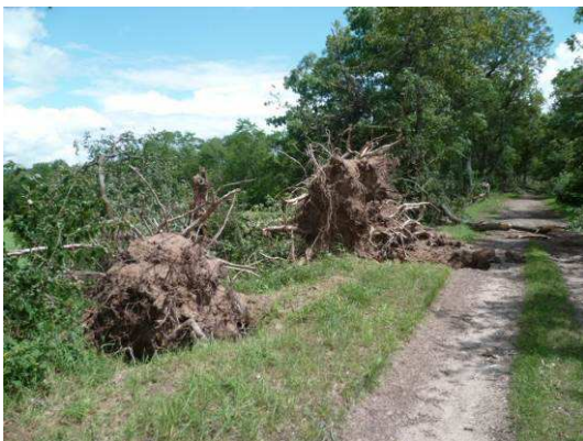
Figure 3 : crête avec arbres déracinés en juin 2012 (vue vers l'amont -source DDT58)
