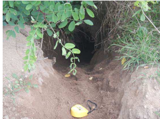
Figure 10 : terrier avec diamètre supérieur à 15cm sur talus coté val
