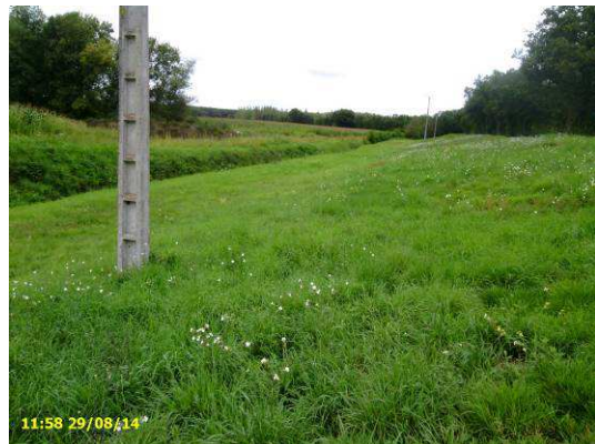
Figure 14 : pylônes en pied de talus coté val
