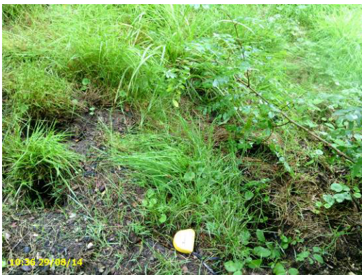
Figure 7 : terriers sur le haut du talus coté val (vus depuis la crête de la digue)
