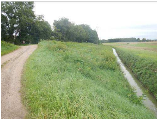
Figure 13 : fossé en pied de digue coté val vu vers l'amont
