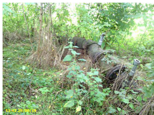
Point 349 : canalisation vue en crête coté val
