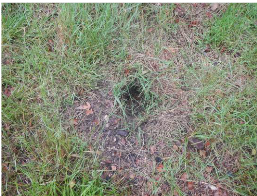
Terrier 5cm de diamètre – crête tronçon n°1
