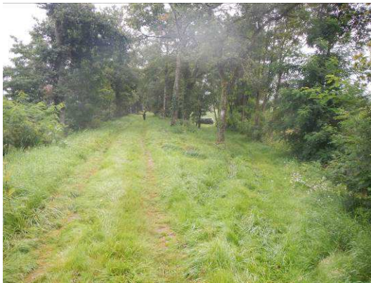
VLG sur les 2 talus du tronçon n°2 (vue vers l'amont)
