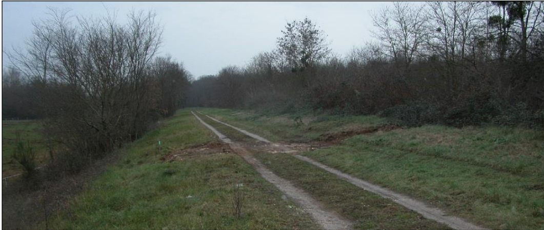
Figure 48 : levée de Beffes-Herry - réparations d'urgence lors de la crue de décembre 2003 (crédit photo DREAL Centre-Val de Loire)
