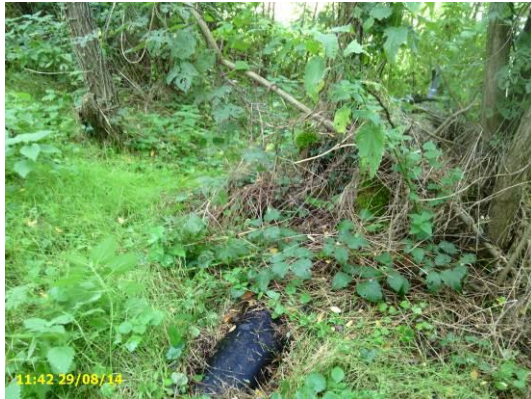
Point 349 : canalisation PVC apparente en crête (disparaissant vers crête côté Loire)
