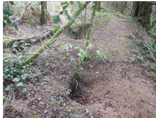
Figure 18 : terriers abandonnés sur talus côté Loire
