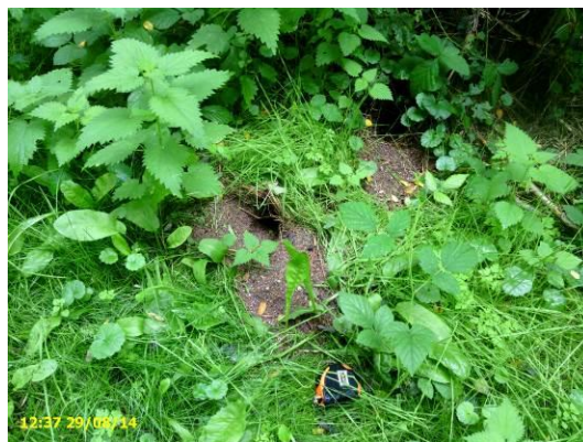
Terrier 5cm diamètre – talus val sur section n°2
