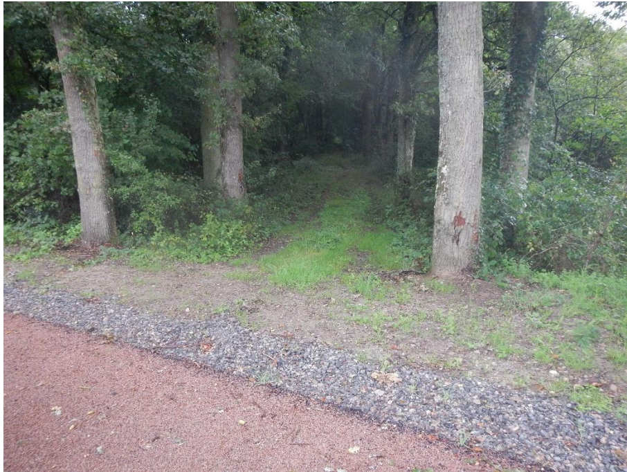
Figure 36 : Raccordement amont entre la digue de protection du val et le remblai du Canal Latéral de la Loire (vu vers l'aval)
