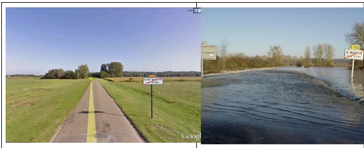
Figure 50 : déversoir de Saint-Martin-sur-Ocre aujourd'hui (à gauche) et lors de la crue de décembre 2003 (à droite) (image Google Earth - crédit photo DREAL Centre-Val de Loire)
