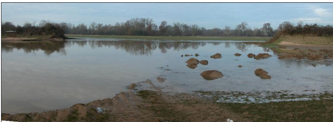
Figure 49 : Brèche dans la digue de Mauboux à Livry (58) - Crue de 2003 (crédit photo DREAL Centre-Val de Loire)
