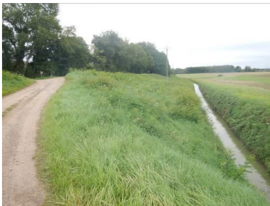
Figure 19 : fossé en pied de digue côté val vu vers l'amont
