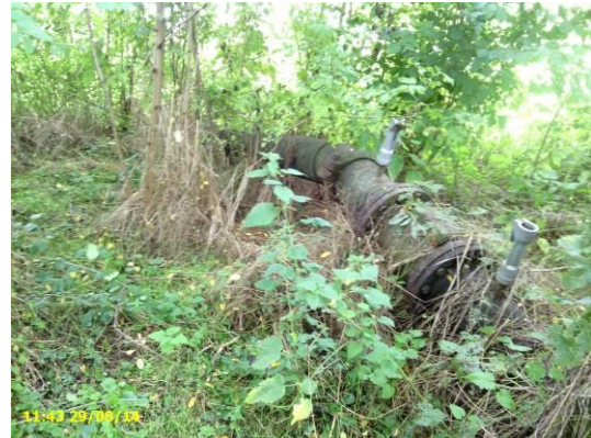
Point 349 : canalisation vue en crête côté val
