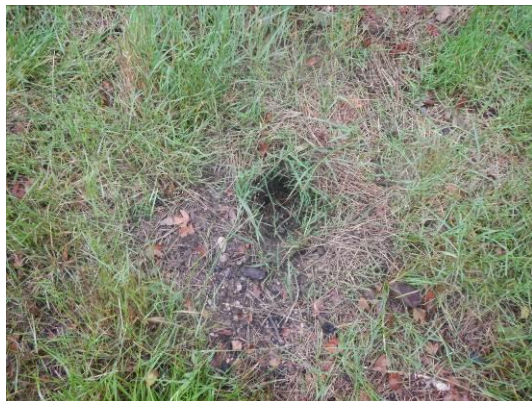
Terrier 5cm de diamètre – crête section n°1
