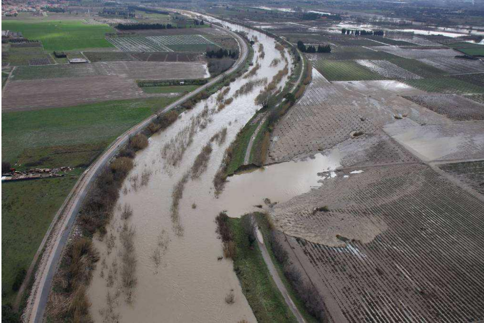
Figure 52 : brèche de Pia sur l'Agly - crue du 6 mars 2013 - (photo : protection civile des Pyrénées-Orientales)
