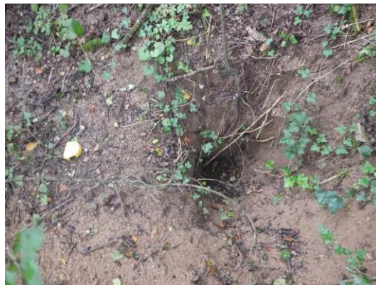
Terrier 10cm diamètre – section n°2 sur talus Loire
