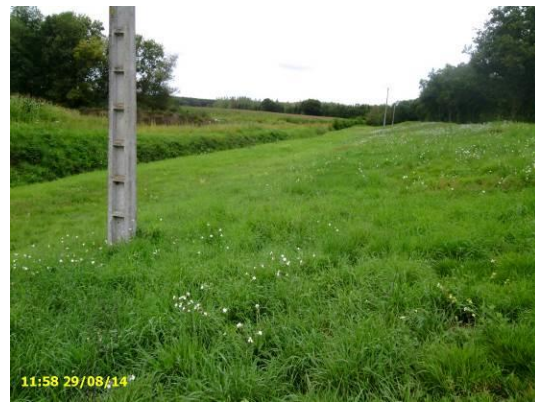
Figure 20 : pylônes en pied de talus côté val
