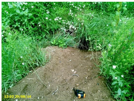
Terrier diamètre supérieur à 15cm – talus val sur section n°2
