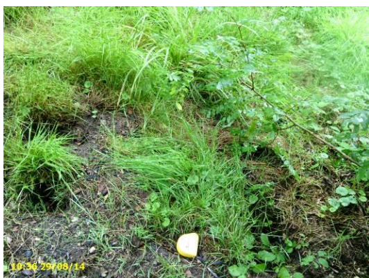
Figure 13 : terriers sur le haut du talus côté aval (vus depuis la crête de la digue)
