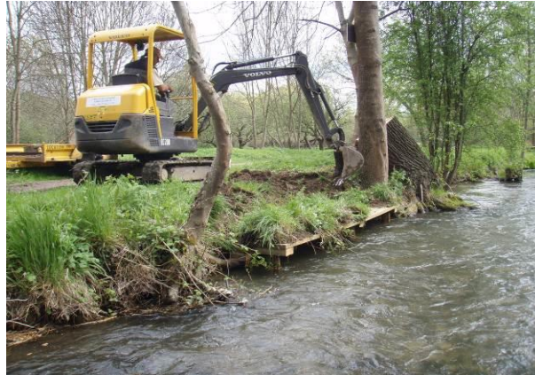
Figure 37: Création d'un abri sous berge
