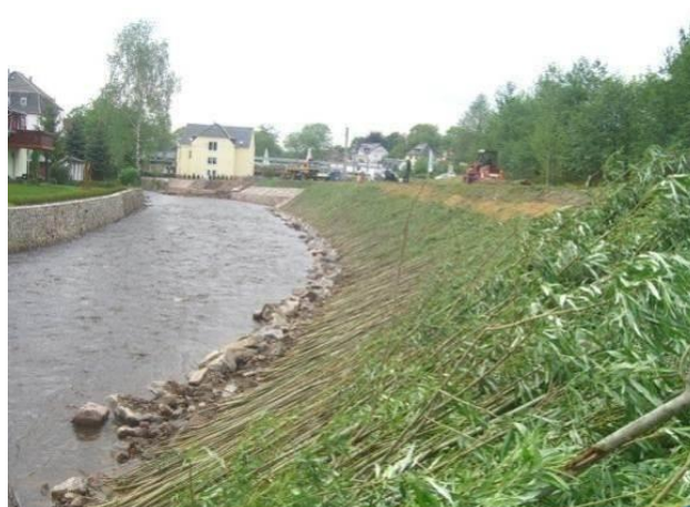
Figure 35: Mise en œuvre d'une couche de branches à rejet
