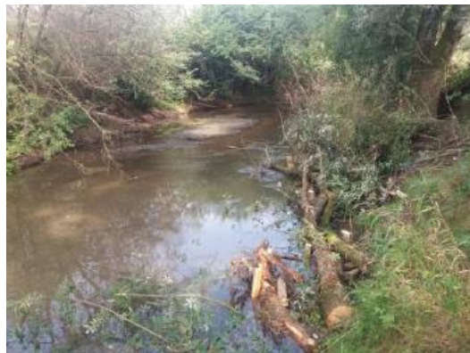
Figure 36: Exemple d'ancrage d'arbre en berge.
