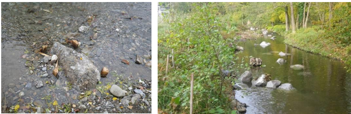
Figure 30: Bloc ancré avec des pieux bois- Pose de bloc pour diversification du lit
