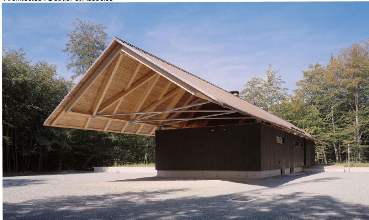
Equipement forestier à Tenneville (Belgique) Architectes : Dethier et Associés
