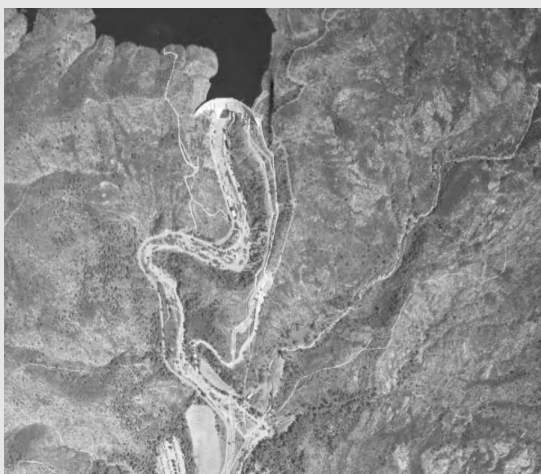
Le site du barrage avant la rupture © IGN – photo aérienne août 1955
