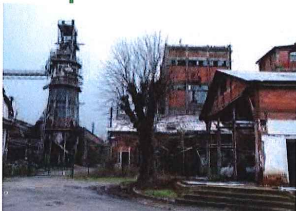
Démolition du site de LAMBIOTTE à Prémery (usine spécialisée dans le charbon de bois et la chimie)
