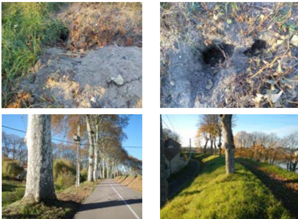
Figure 33 : Débouchés de terriers (en haut) et végétation sur la digue (en bas) (Egis Eau, 2014)
