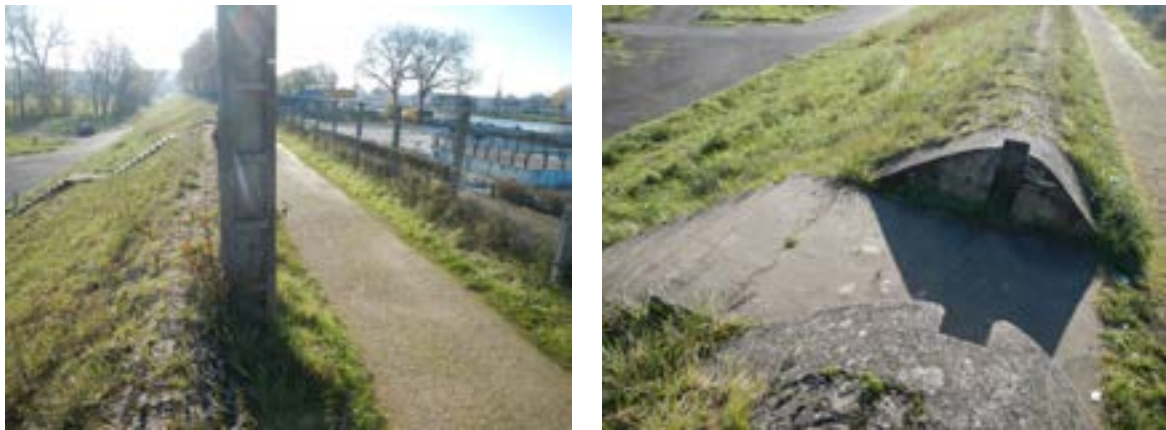
Figure 11 : Vues d'ensemble de la digue sur la levée du canal de la Jonction (haut) et zoom sur la banquette (bas) (Egis Eau, 2013)
