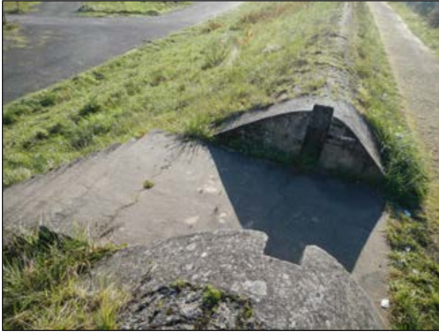
Figure 53 : Bouchure levée du canal de la Jonction face à la piscine du canal – val de Nevers, Sermoise et Challuy (Source : Egis Eau, 2014)
