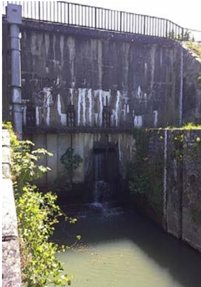
Figure 15 : Ancienne écluse du port de la Jonction (Source : Egis Eau, 2014)
