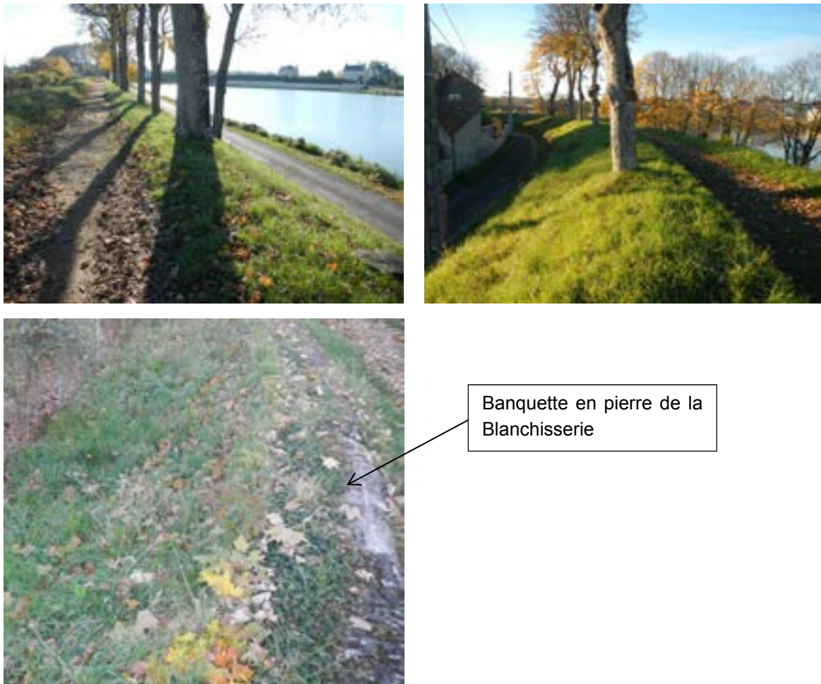
Figure 12 : Vues d'ensemble de la digue sur la levée de la Blanchisserie (haut) et zoom sur la banquette (bas) (photos : Egis Eau, 2013)
