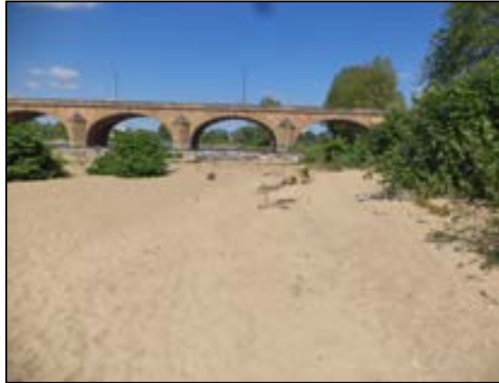
Figure 64 : Banc alluvionnaire en pied de digue de la levée du Plateau de la Bonne Dame (Egis Eau, 16/05/2014)
