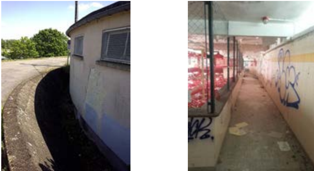
Figure 31: Bâtiments encastrés de l'ancienne piscine de la Jonction (Egis Eau, 2014)
