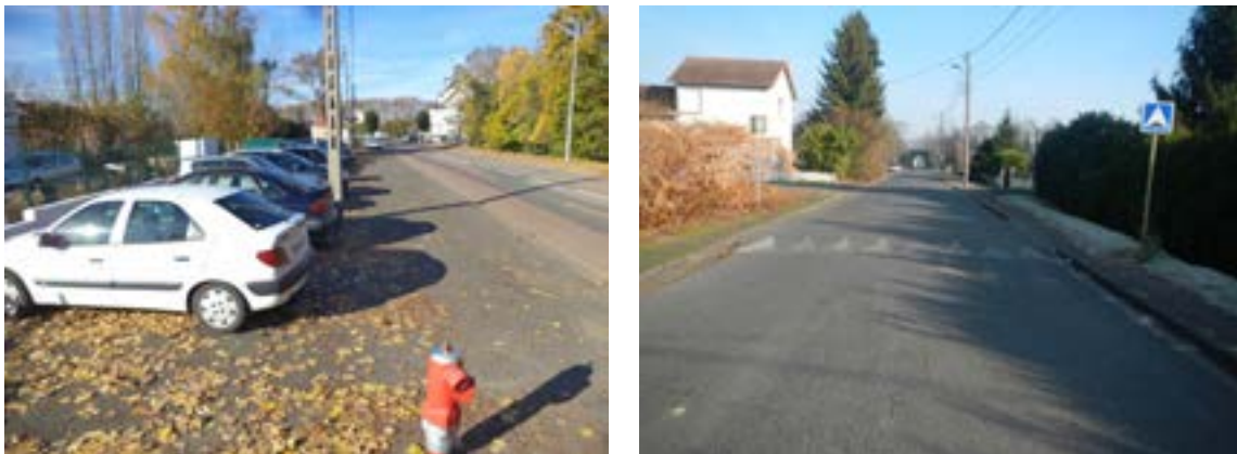
Figure 14 : Vues d'ensemble de la digue sur la levée de Sermoise 2 e section (gauche) et la levée de Gimouille (droite) (photos : Egis Eau, 2013)
