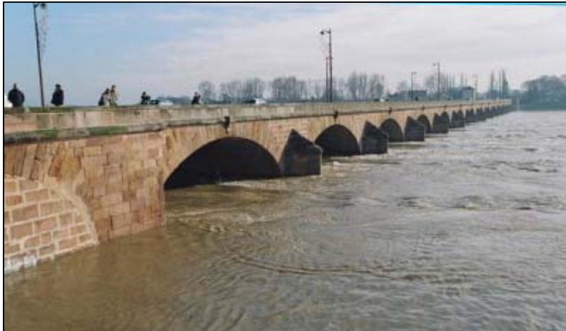
Figure 4 : Ligne d'eau sous le pont de Loire en décembre 2003 à Nevers (58)
