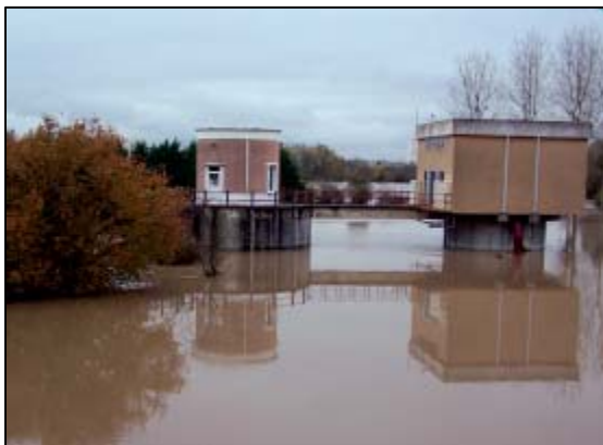
Figure 5 : Station de captage de Nevers en rive gauche lors de la crue de novembre 2008 (source EGRAIN rapport vulnérabilité des enjeux)
