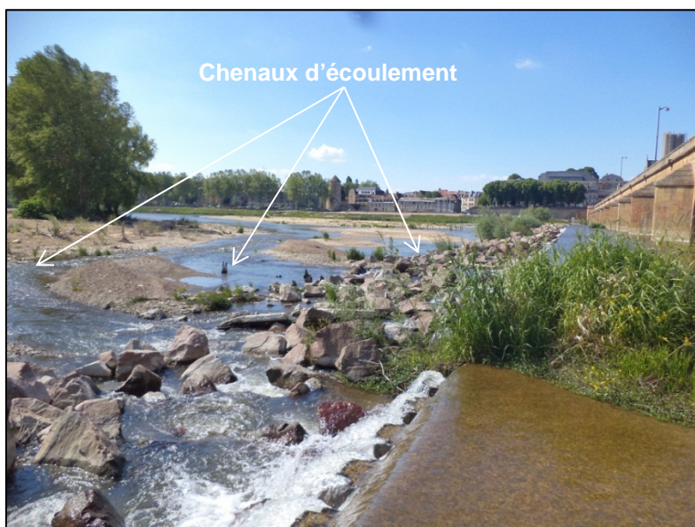
Figure 24 : Seuil en aval du pont de Loire (Egis Eau 16/05/2014)
