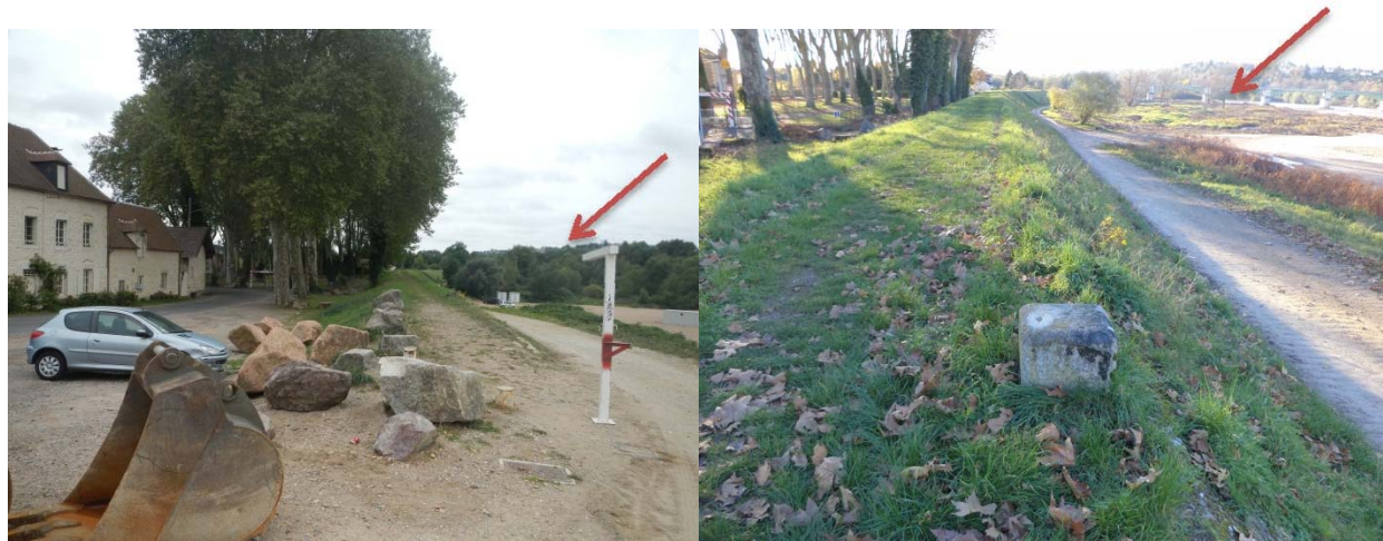
Figure 26 : Déboisement de la forêt alluviale au droit de la levée de la Bonne Dame. A gauche : août 2013 et à droite : décembre 2013 (Egis Eau, 2013)
