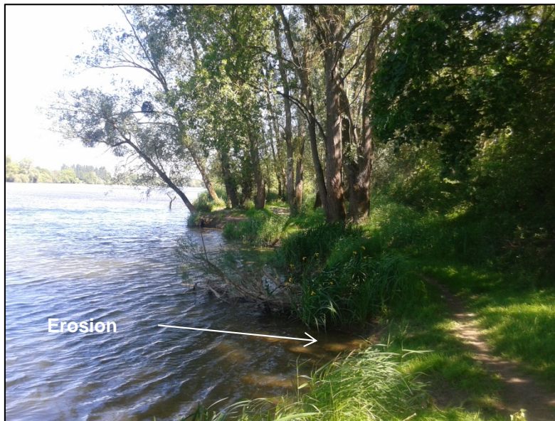
Figure 16 : Erosion et végétalisation de la rive gauche près de la levée du canal de la Jonction - (Egis Eau 16/05/2014)
