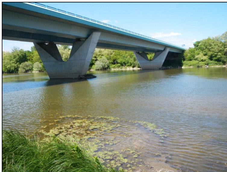
Figure 9 : Pont de l'autoroute traversant la Loire (Egis-Eau 16/05/2014)
