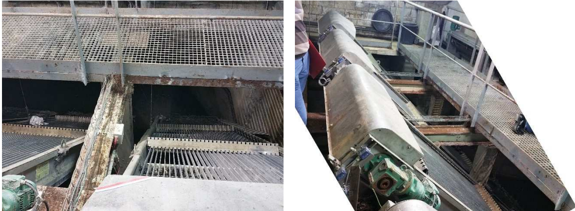
Figure 4 : Etat - Dégrilleurs fins
