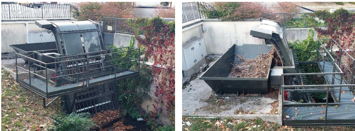
Figure 3 : Etat - Dégrilleur grossier
