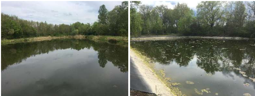
Photo 12 : A gauche bassin de l'A77 végétalisé, à droite bassin de la plateforme (in situ IEA)
