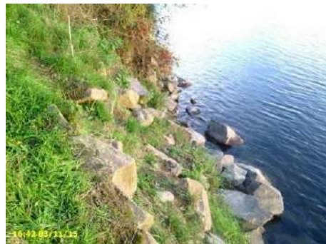
Figure 49 : protection de la berge en enrochements libres avec quelques blocs déstabilisés
