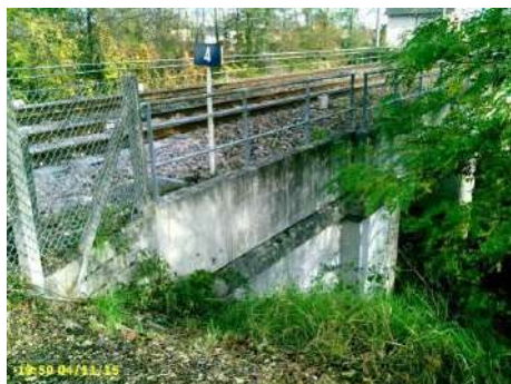
Figure 22 : culée du pont de la route départementale encastrée dans la digue, vue vers l'amont
