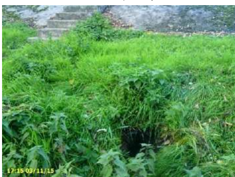
Figure 11 : terrier de diamètre supérieur à 30cm en milieu de talus coté Loire (sous parement bétonné)
