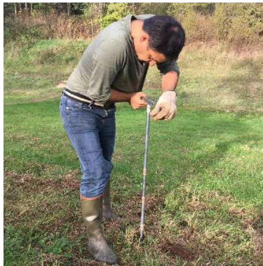
Photo 32 : Réalisation d'un sondage sur la digue de Maison Neuve (in situ IEA/Nevers Agglomération)
