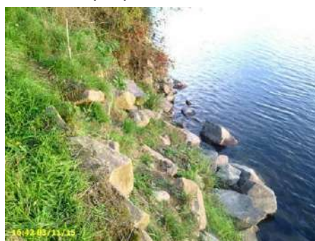
Figure 12 : protection de la berge en enrochements libres avec quelques blocs déstabilisés
