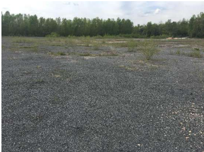
Photo 18 : Plateforme stabilisée (in situ IEA)
