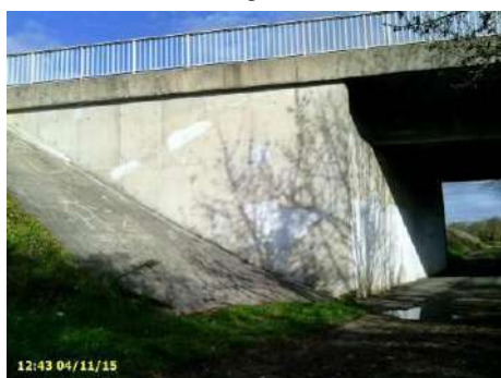
Figure 22 : culée du pont de la route départementale encastrée dans la digue, vue vers l'amont
