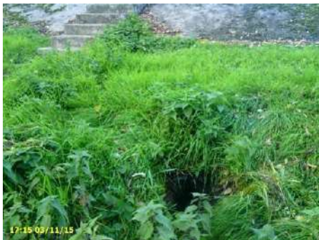
Figure 48 : terrier de diamètre supérieur à 30cm en milieu de talus coté Loire (sous parement bétonné)
