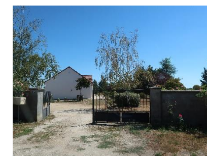
Habitation du lieu-dit « Cocheriot »
