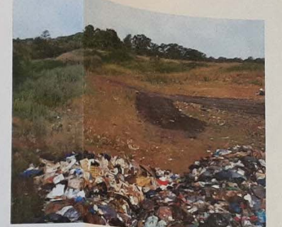
6 - Plate forme remblayée en cours
