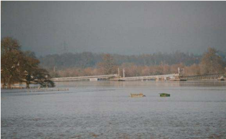
Figure 36: Photo prise lors de la crue de 2008 - Vue du bassin C depuis l'amont
