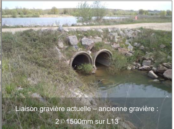
Figure 3-9 : Liaison gravière actuelle – ancienne gravière (2 \varnothing 1500mm sur L13)
