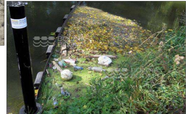
Exemple de dromes retenant des débris
