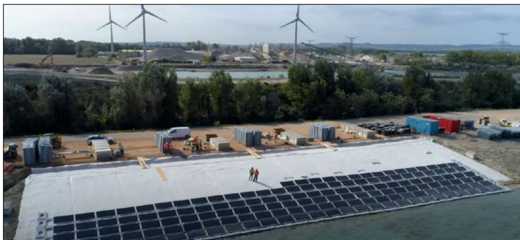
Exemple d'une bâche de protection
