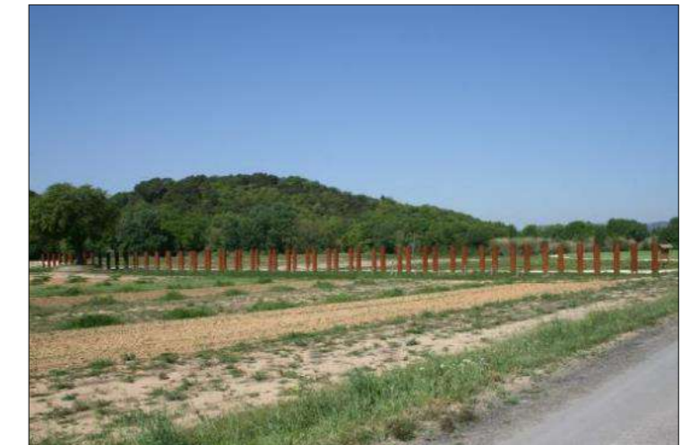
Exemple de pieux métalliques dans un champ (peigne anti-embâcles)
