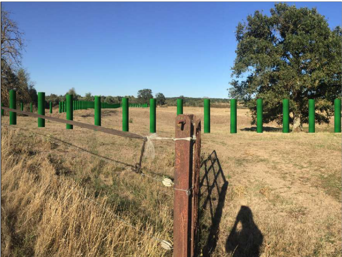
Photomontage d'une vue au sol sur le peigne anti-embâcles Visuellement assimilable à une clôture agricole
