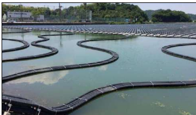
Liaisons électriques entre les îlots flottants et les transformateurs
