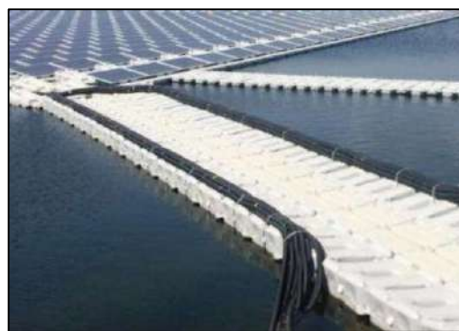
Liaisons électriques entre les îlots flottants et les transformateurs
