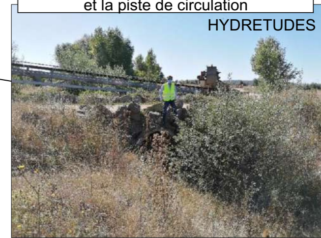
2 Ø 1500mm sur Lr1 Buses sous les bandes transporteuses et la piste de circulation
