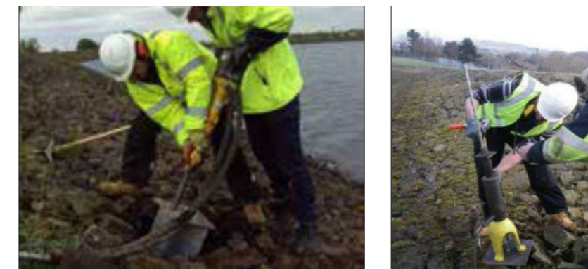
Ancrage sur berge
