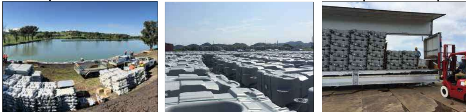
Exemples de stockage de matériel sur une zone de chantier
