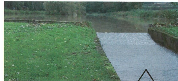
Déversoir de crue en fonctionnement
