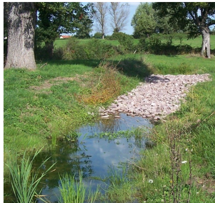
Exemple de filtre à gravier installé entre la pêche et le ruisseau longeant le plan d'eau (plan d'eau créé en dérivation)
