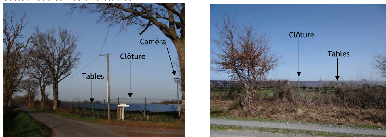
Figure 40 et Figure 41: Exemples de centrales photovoltaïques au sol existantes en vue immédiate dans un contexte bocager
