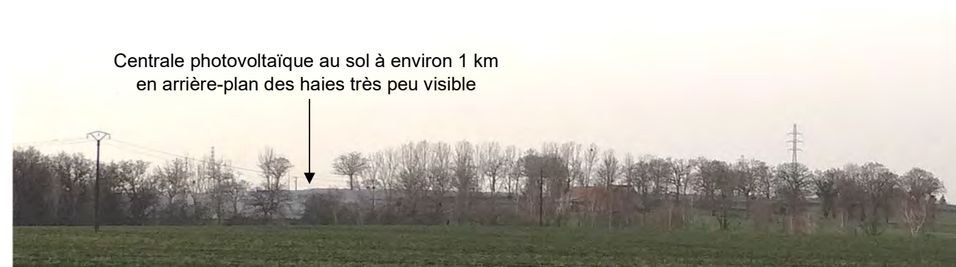
Figure 48. ZOOM. Exemple d'une centrale photovoltaïque au sol dans un contexte bocager perçue à environ 1 km (ETD)
