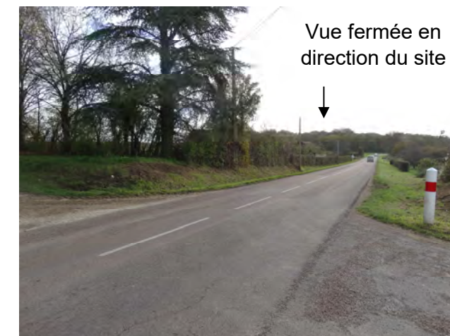
Figure 9 : Vue sur la RD1 depuis Moulin neuf
