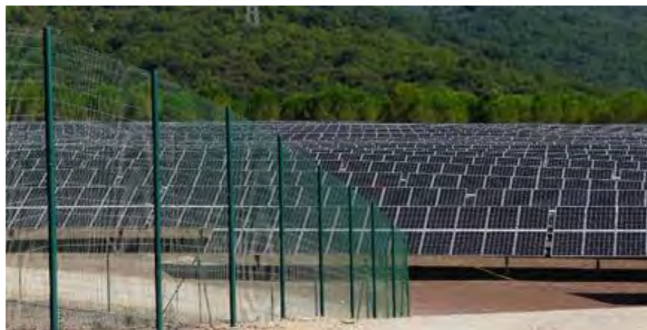
Figure 101 : Exemple de clôture périmétrique
