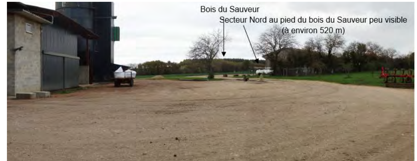
Figure 87 : Vue vers le nord-est au nord de la maison de la ferme de Mirebeau (illustration 29)
