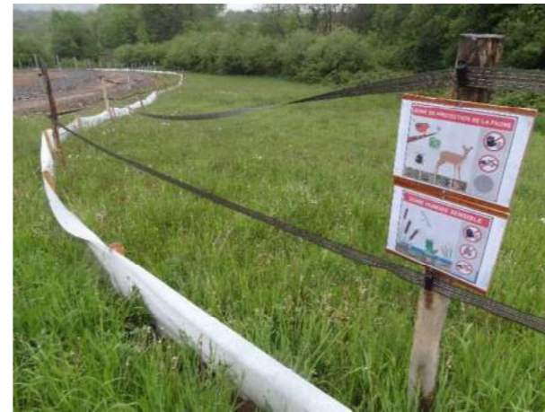
Figure 19. Exemple de mise en défens de zone sensible en phase chantier (Source Crxeco)
