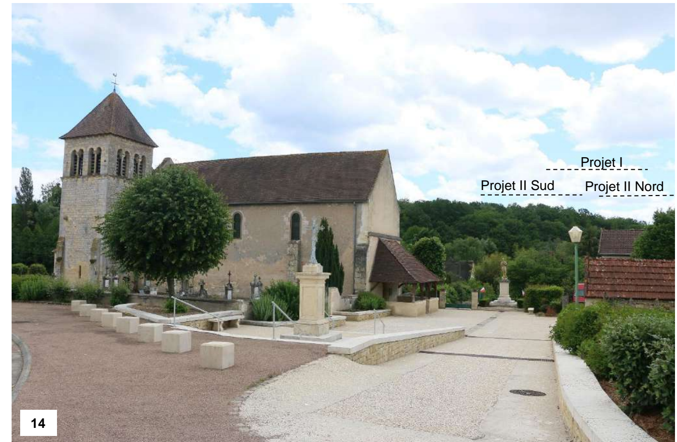
Figure 15 : Depuis l'église de Sauvigny-les-Bois en direction du projet (© ATER Environnement, 2019)
