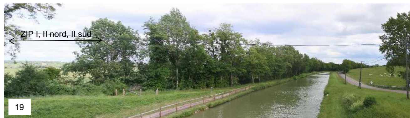
Figure 21 : Vue du GR03 qui longe le canal latéral à la Loire (© ATER Environnement, 2019)
