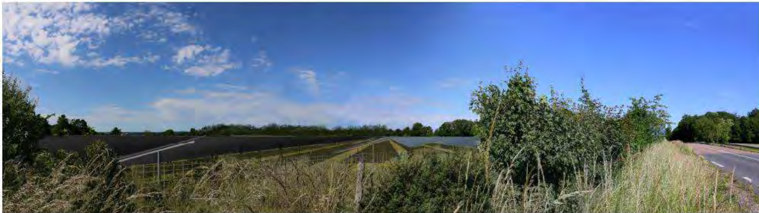
Figure 98 : Vue depuis les abords de la D981 (© I'M IN ARCHITECTURE, 2020)
