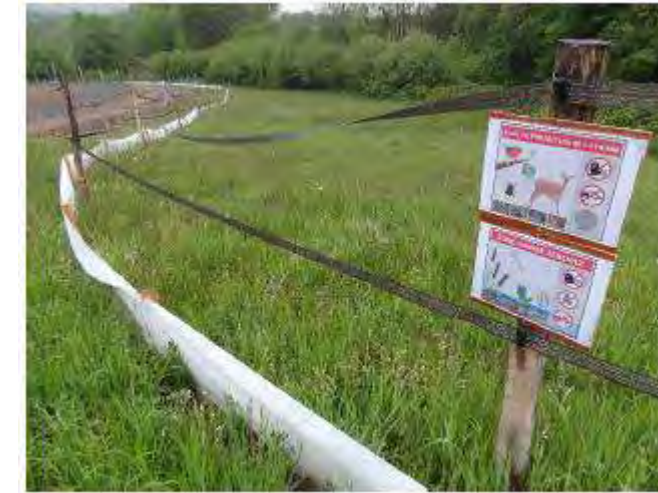
Figure 108 : Exemple de mise en défense de zone sensible en phase chantier (source : CREXECO, 2021)
