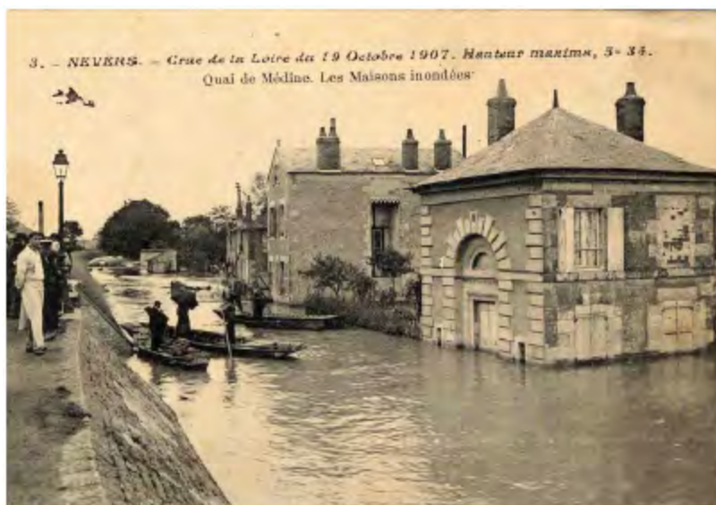
Fig. 6. : Crue du 19 octobre 1907 au niveau des quais de Médine à Nevers
