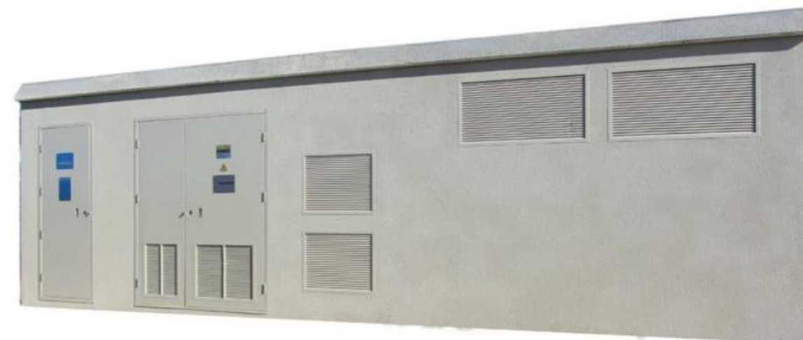
Figure 23: Exemple de poste de livraison
