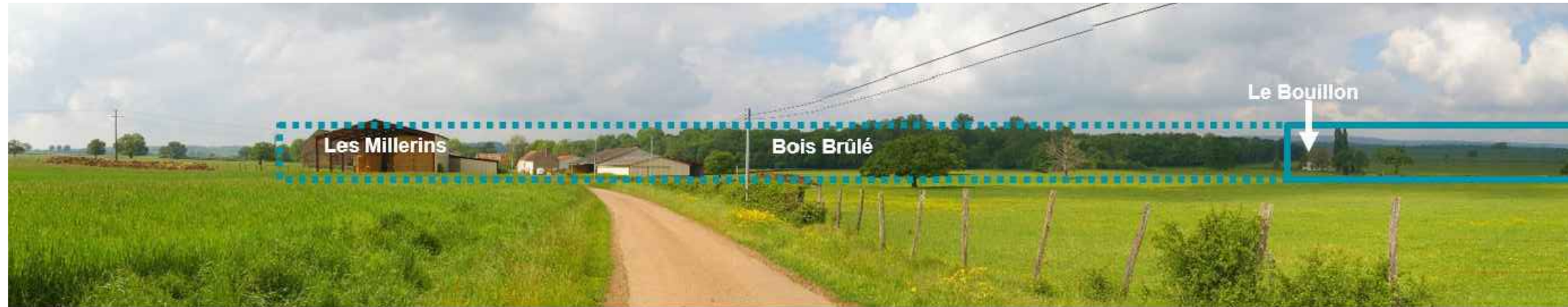
VUE 5 (PC 7 environnement proche) vue depuis l' Est du hameau des Millerins
