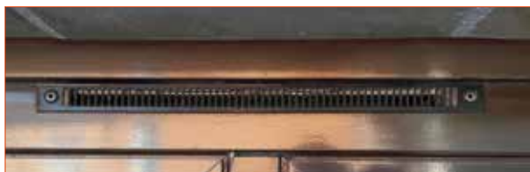
Entrée d'air pour VMC par extraction
