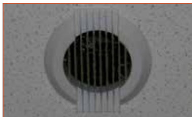
Bouche d'extraction pour VMC par extraction
