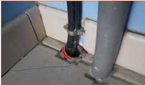
Exemple de défauts d'étanchéité
