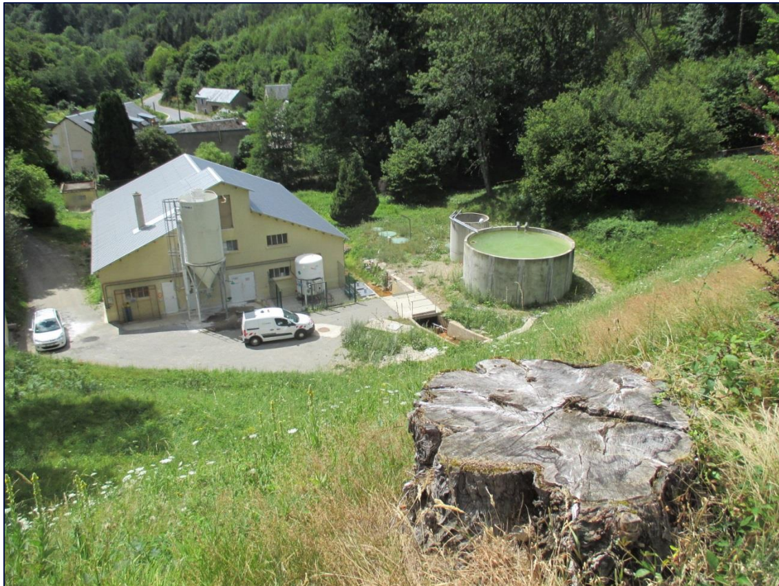
Figure 30 : Station de traitement d'eau potable en aval immédiat du barrage (Source : AVP -2018)
