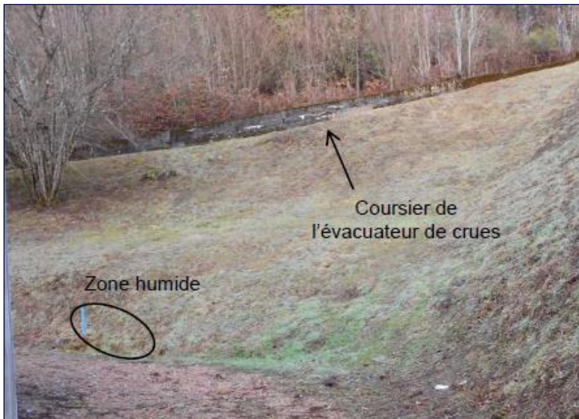
Figure 19 : Zone humide rive droite (Source : VTA - 2017)
