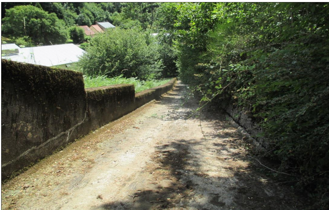
Figure 28 : Vue sur le coursier (Source : AVP – 2018)
