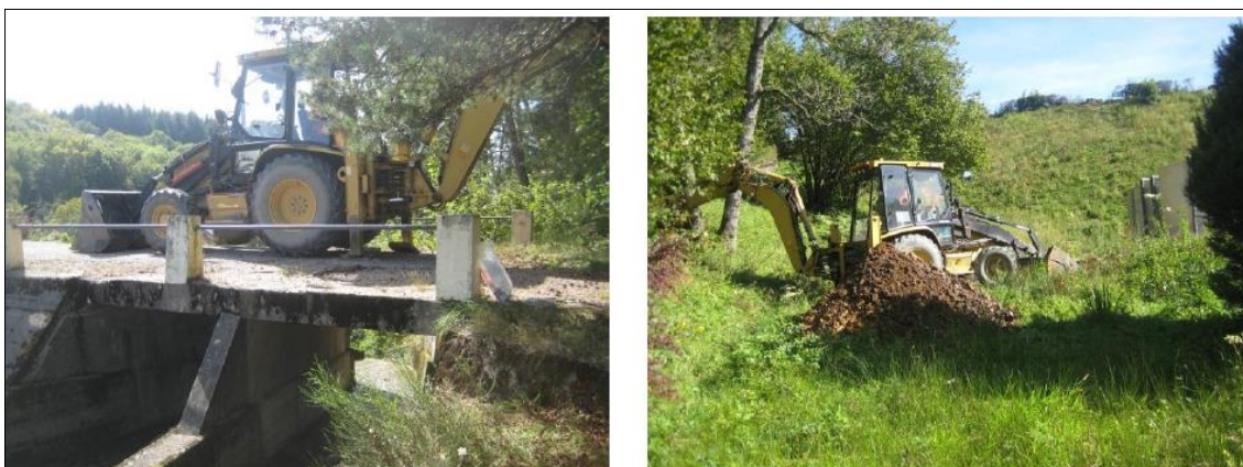
Figure 41: Chargeuse-pelleteuse utilisée pour des sondages géotechniques de 2014
