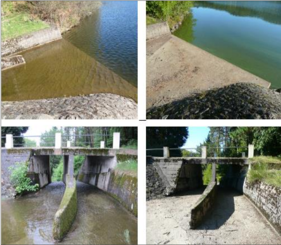
Figure 25 : Photographies de l'évacuateur de crues actuel (Source : AVP)
