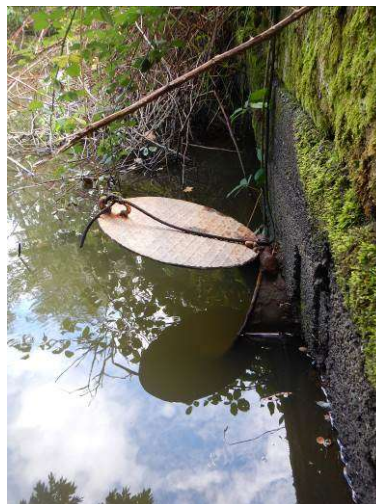
Point 340 : vue de l'ouvrage coté val (tronçon n°1) avec clapet anti-retour
