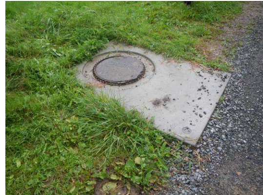
Regard sur dalle en béton à proximité de la station de traitement AEP (tronçon n°5)
