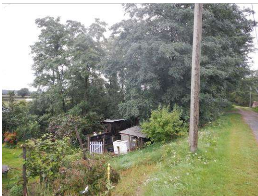
Poteaux en bois au niveau du tronçon n°4 (vu vers
