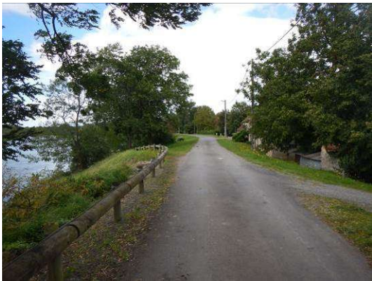
Figure 5 : vue de la digue vers l'aval avec pied de talus en contact avec lit vif de la Loire
