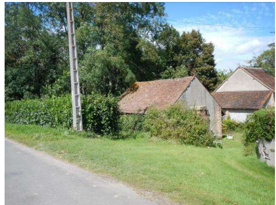
Figure 8 : bâtiment encastré sur talus coté val
