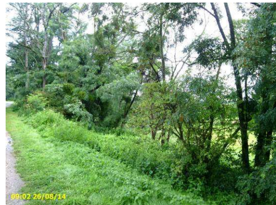
Végétation clairsemée sur talus coté val au niveau du tronçon n°4
