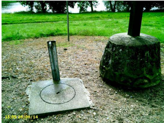
Tampon en béton sur crête coté Loire (tronçon n°2)
