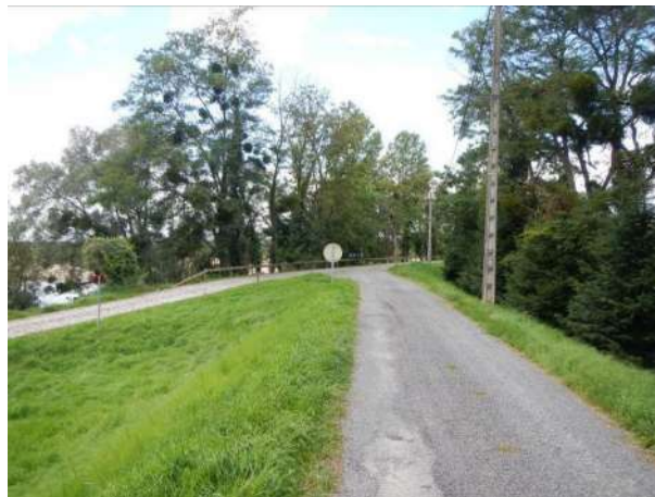
Pylônes en béton en amont du tronçon n°2
