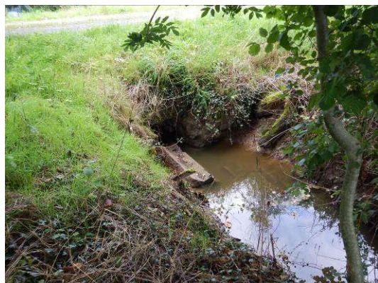
Point 340 : vue de l'ouvrage coté Loire (tronçon n°1)
