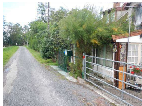
Figure 4 : maison encastrée sur talus coté val de la digue
