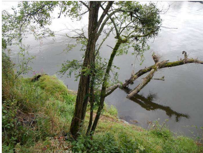
Arbre arraché au niveau de la berge (tronçon n°5)
