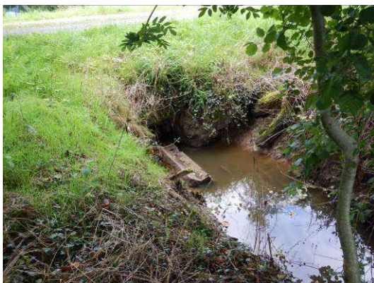
Figure 3 : ouvrage traversant sous la digue vue sur la face amont (talus coté Loire)
