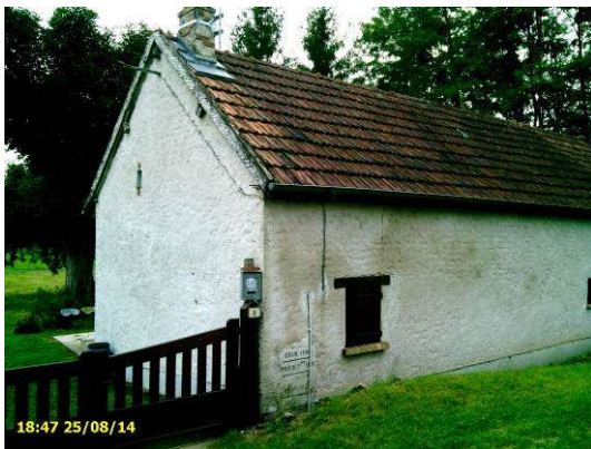
Figure 13 : bâtiment en castré sur le bas du talus coté Loire
