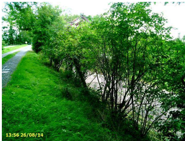
Clôture grillagée au milieu du talus coté val (tronçon n°1 - vu vers l'aval)
