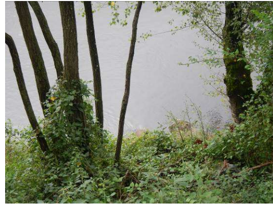
glissement au niveau du bas de talus coté Loire (tronçon n°5)
