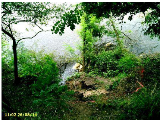
Figure 21 : vue du glissement depuis le haut du talus coté Loire (tronçon n°5)
