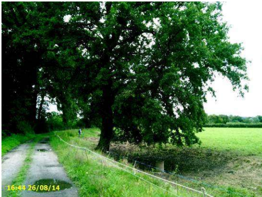
Arbre isolé sur bas du talus coté val (tronçon n°3)
