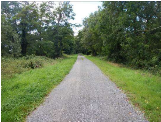
Figure 1 : piste en crête de digue vue vers l'aval (végétation dense de part et d'autre)
