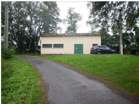
Bâtiment de la station de traitement AEP vue depuis le pied de talus coté val (tronçon n°5)
