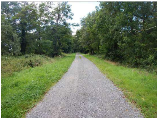
Végétation généralisée sur les 2 talus de la digue au niveau du tronçon n°1 (vue vers l'aval)
