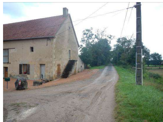
Pylônes en béton en amont du tronçon n°5 (vu vers
