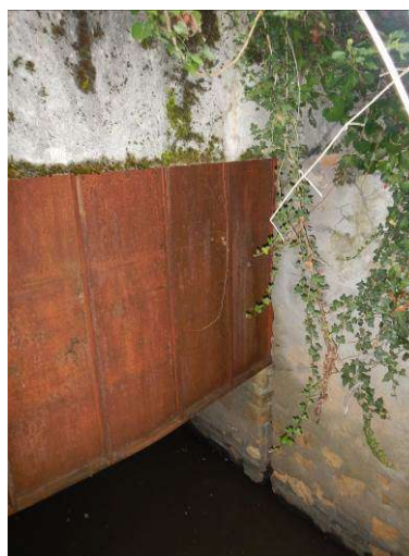
Point 341 : vue de la martelière en dessous de l'ouvrage (fossé en eau au niveau tronçon n°3)
