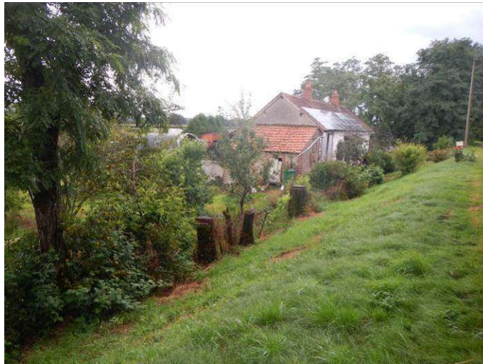
Souches en pied de talus coté val (vues vers l'amont au tronçon n°4)
