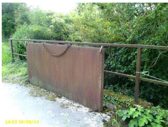
Point 341 : ouvrage avec martelière coté val (tronçon n°3)
