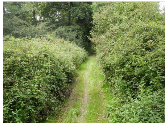
Figure 12 : crête de la digue vue vers l'aval avec sentier
