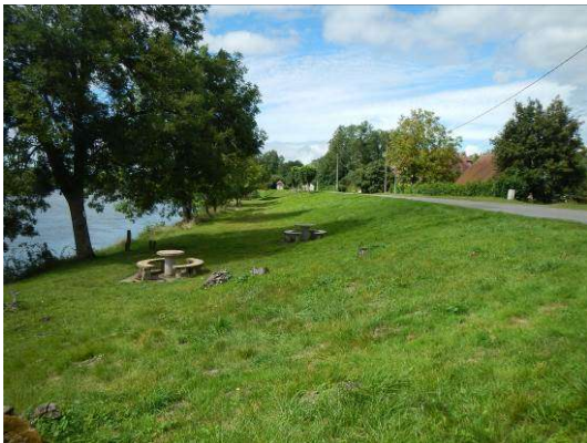
Talus coté Loire vu vers l'aval (tronçon n°2)
