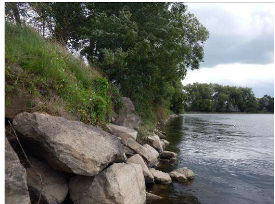
Figure 6 : renforcement en enrochements libres de la berge (vue vers l'amont)
