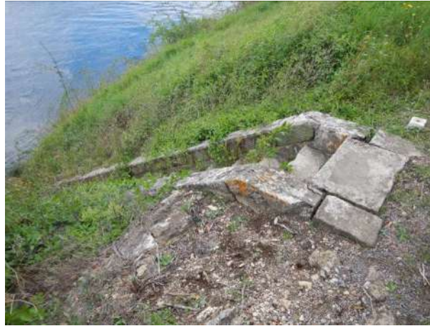
Escalier en pierres sur talus coté Loire (tronçon n°2)
