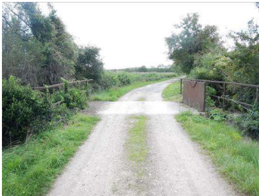
Figure 9 : ouvrage traversant en aval du tronçon (vu vers l'aval)
