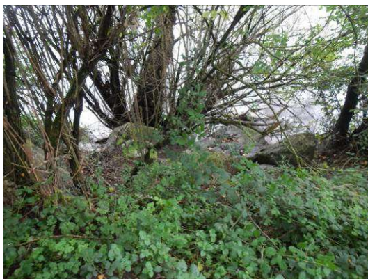
Figure 19 : enrochements libres en protection de la berge de la Loire
