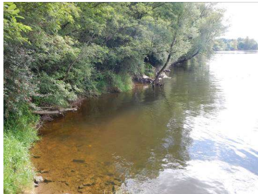
Enrochements intermittents au niveau de la berge de la Loire (vus vers l'amont - tronçon n°5)
