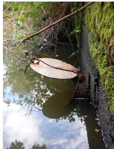
Point 340 : vue de l'ouvrage côté val (section n°1) avec clapet anti-retour
