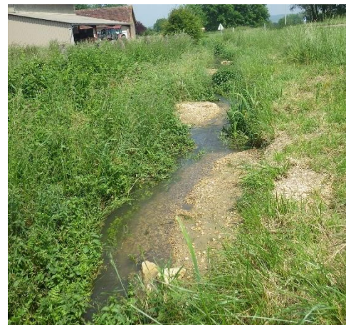
Figure 28: Schéma de principe de banquettes alternées- Réalisation de banquettes
