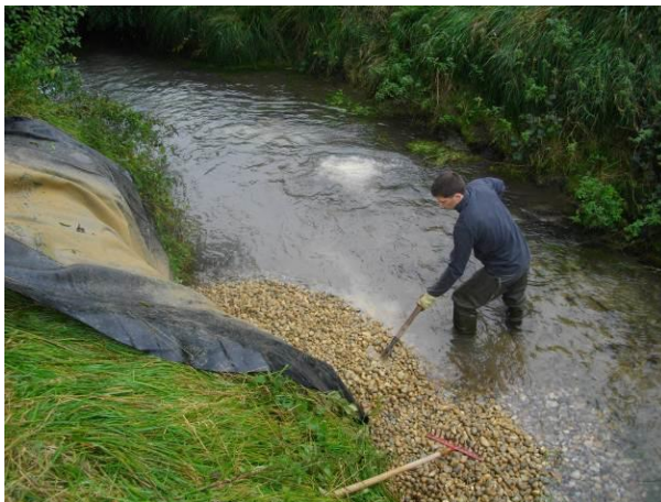
Figure 29: Mise en œuvre des matériaux
