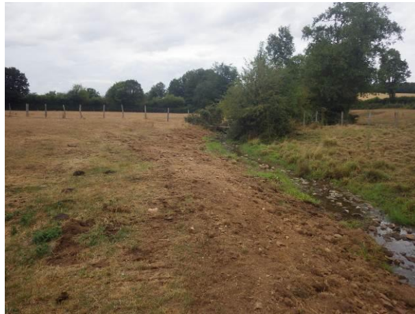
Figure 27: Exemple de retalutage – après travaux
