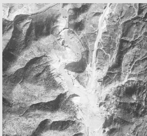
Le site du barrage après la rupture © IGN – photo aérienne décembre 1959
