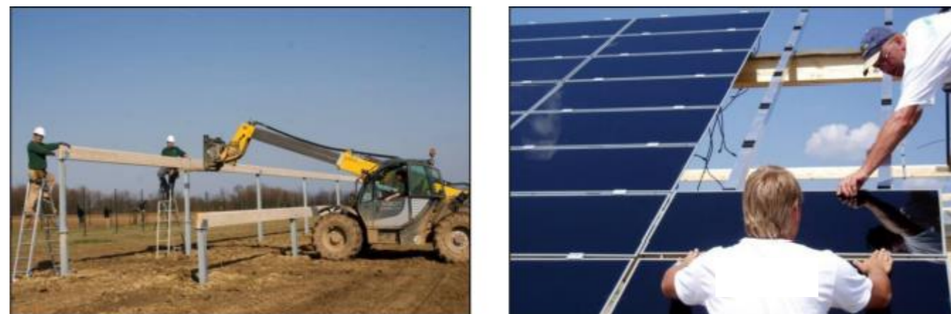
Illustration 20 : Montage des structures porteuses et des modules
