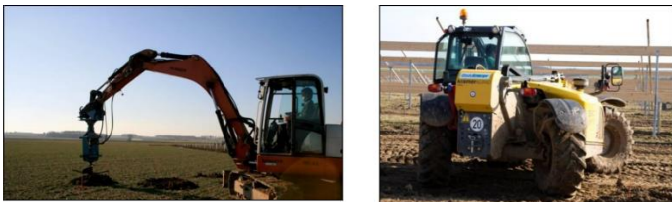
Illustration 19 : Exemple d'engins nécessaires sur le chantier
