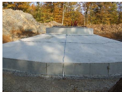
Massif d'éolienne avec ceinture équipotentielle pour MALT
