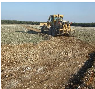
Décapage pour câblage
