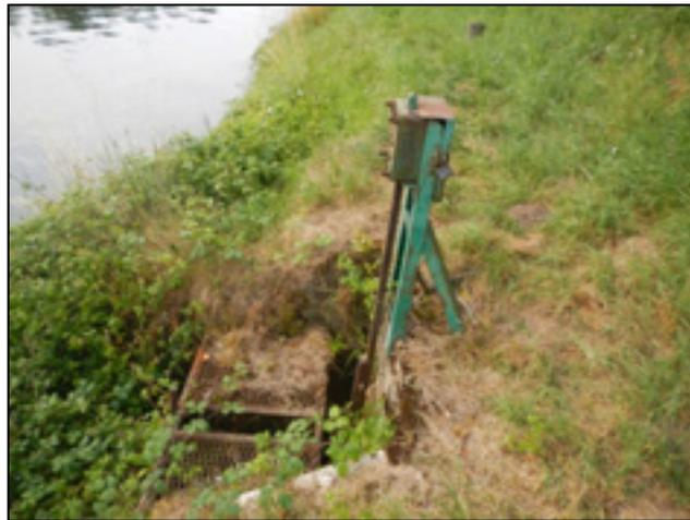
Figure 44 : Vanne en pied de digue, levée de la jonction 3<sup>e</sup> section (Egis Eau, 2013)
