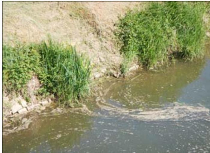
Figure 53 : Etat du perré en pierre en pied de digue sur la levée de la Jonction 3<sup>e</sup> section (Egis Eau, 2014)
