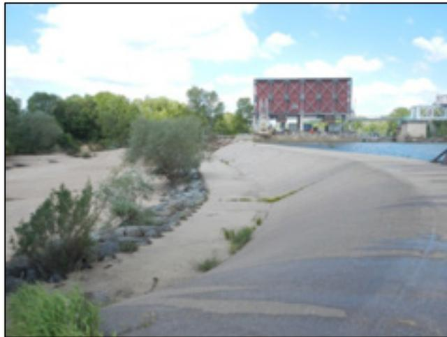
Figure 34 : Déversoir de sécurité du barrage de Saint Léger des Vignes (Egis Eau, 16/05/2014)
