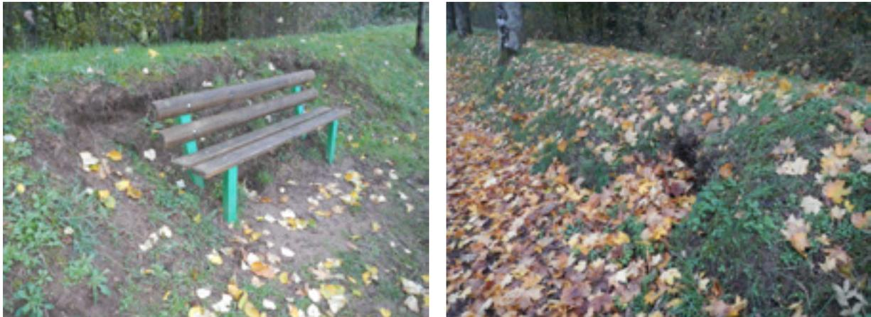
Figure 20 : désordres recensés sur la banquette de la levée de la jonction 2<sup>e</sup> section (Egis Eau, 2014)
