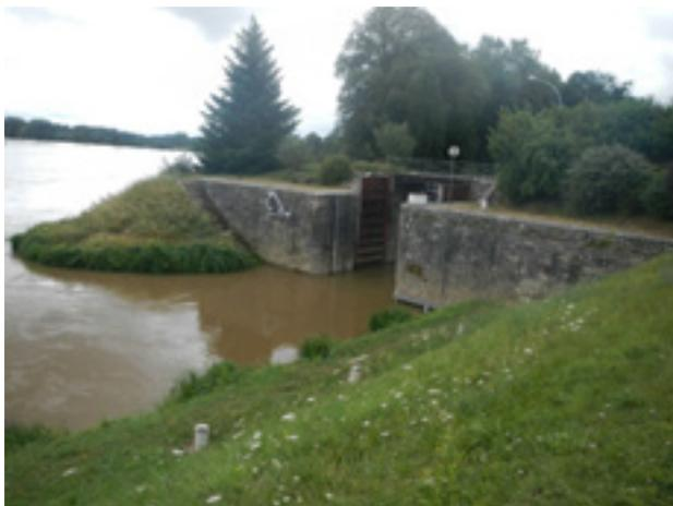
Figure 15 : Portes de garde côté Loire de l'écluse de la Jonction (Source : Egis Eau)
