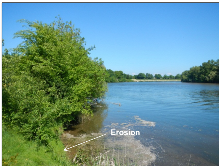
Figure 6 : Zone d'érosion lorsque la berge est à nue - franc de la levée de la Jonction 2ème section - val de Decize (58) (Egis Eau 16/05/2014)
