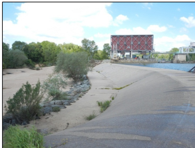
Figure 25 : Déversoir de sécurité du barrage de Saint Léger des Vignes -val de Decize (58) (Egis Eau 16/05/2014)
