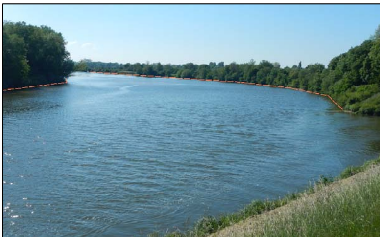
Figure 5 : Vue du coude n°2 depuis l'écluse aval du port de la Jonction - val de Decize (58) (Egis Eau 16/05/2014)
