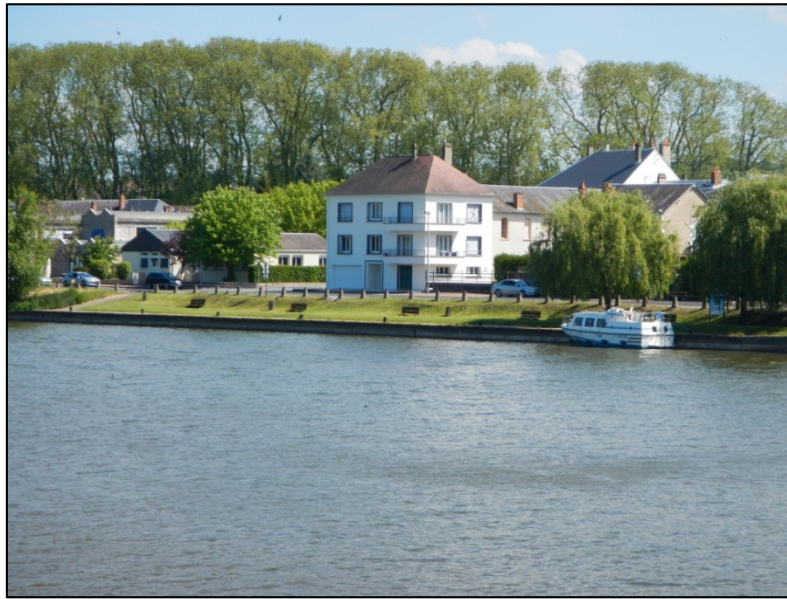
Figure 19 : Quai d'accostage en rive droite à l'aval du pont de la D978a- val de Decize (58) (Egis Eau 16/05/2014)
