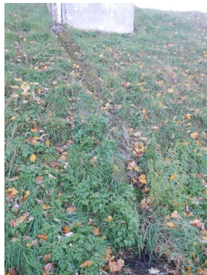
Figure 10 : Poste électrique et conduite sur la levée de la Blanchisserie profil 66
