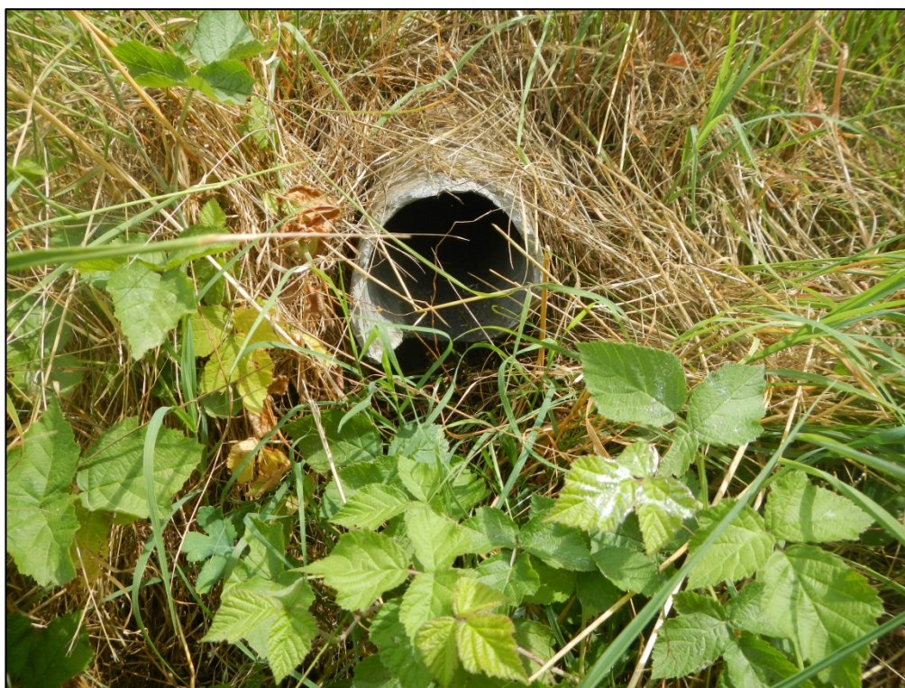
Figure 6 : Canalisation en PVC profil 107 - val de Nevers (58)
