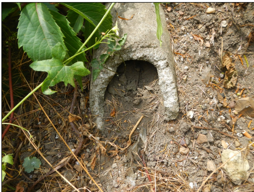
Figure 8 : Canalisation profil 108 - val de Nevers (58)
