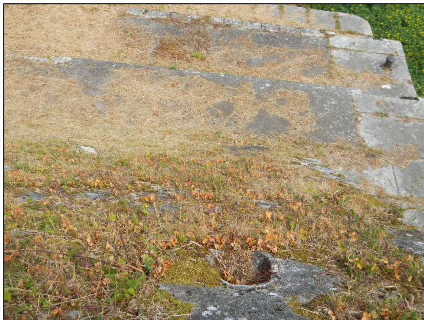
Figure 3 : Canalisation P63 côté Loire face à la piscine - val de Nevers
