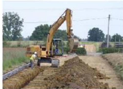
Phase de chantier en zone agricole
