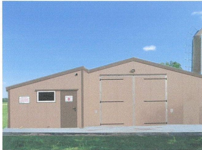
photo poulailler n°V2 – Vue Nord (construction en cours)
