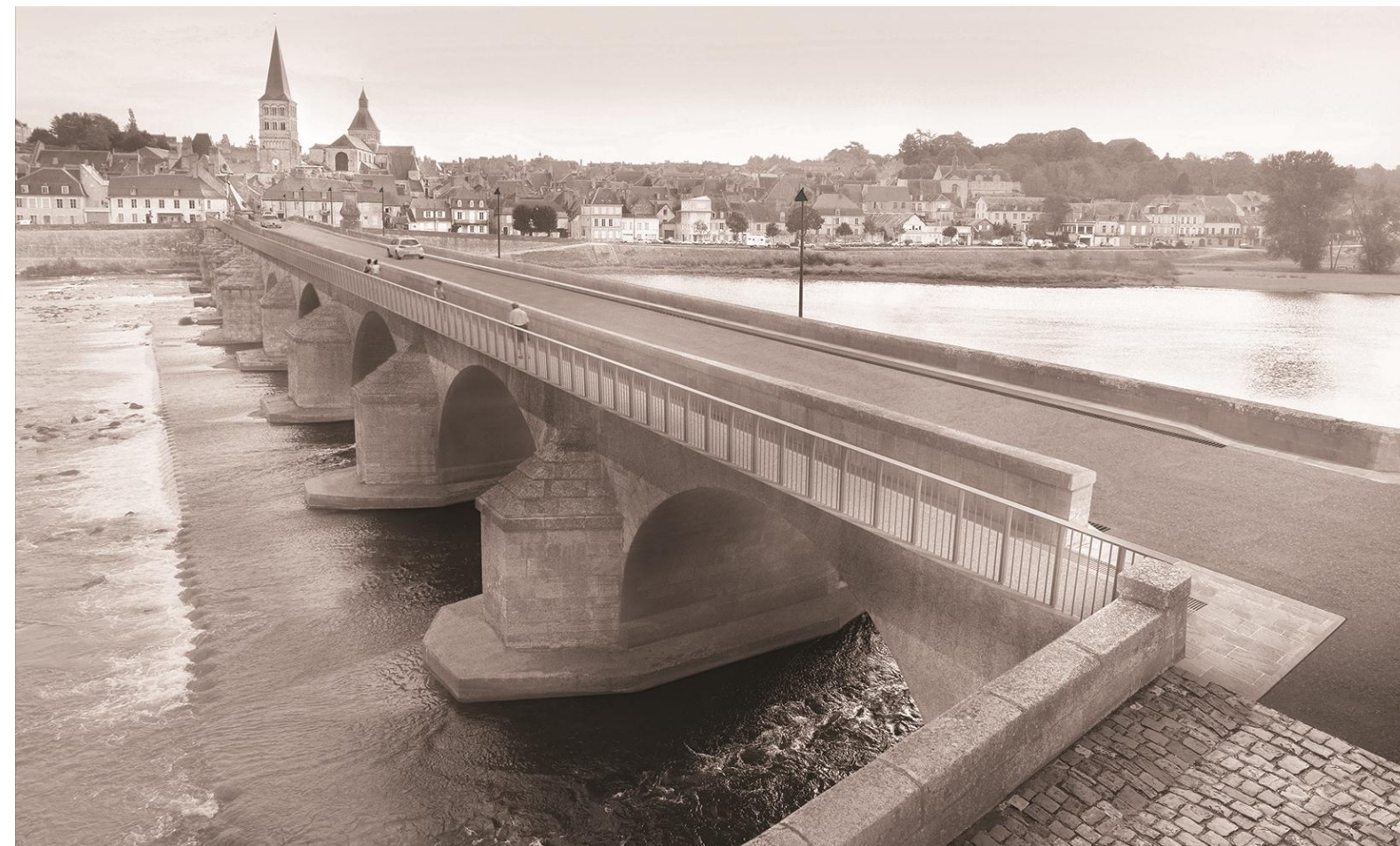
Côté aval : vues de la passerelle et de son belvédère vitré
