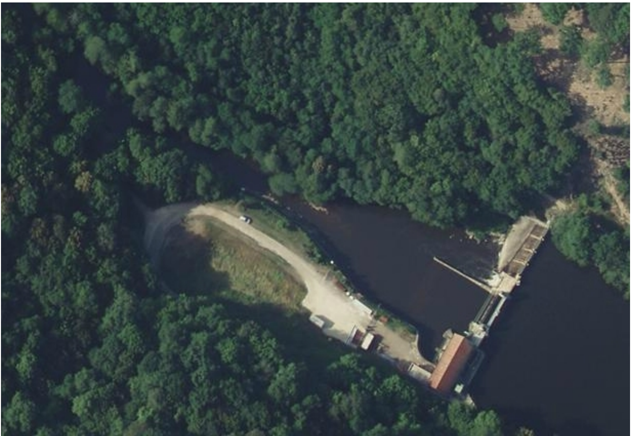
Vue aérienne du barrage de Malassis (source Géoportail)
