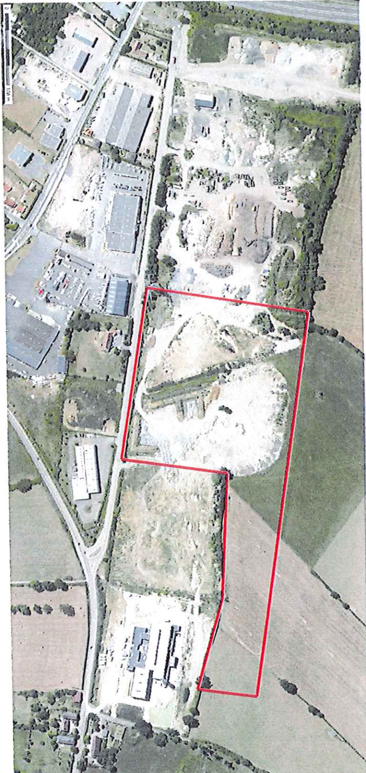
Figure 2 : Vue aérienne de DEVAEL, emprise de projet (source Géoportail)
