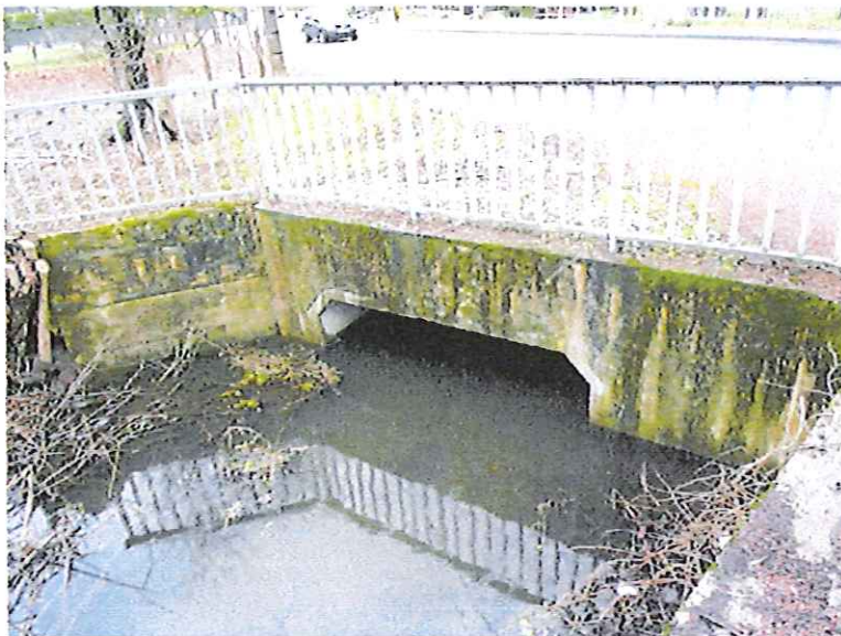
Figure 13 : Passage sous la D 176
