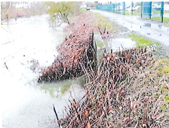
Figure 12 : Exutoire du Guipasse dans le canal
