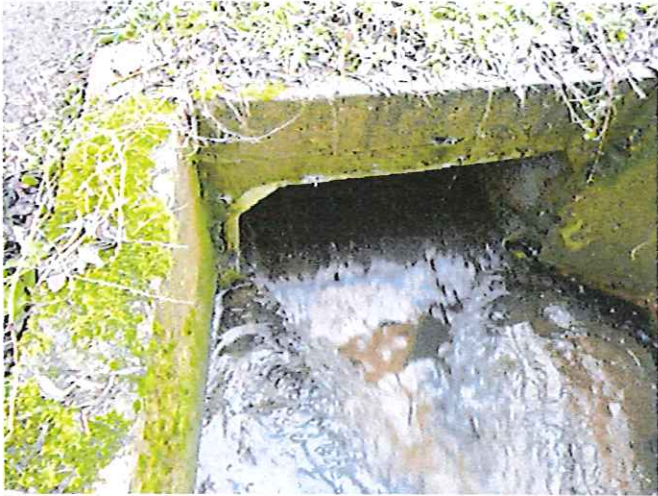
Figure 16 : Ouvrage cadre rue des Maraules
