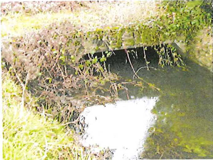
Figure 14 : Passage sous la ligne de la CCI
