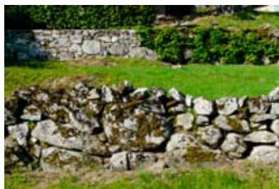
Mur de pierre. Brassy
