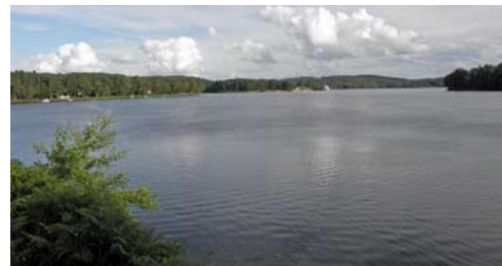
De grands lacs de barrage ouvrent un miroir lumineux au sein de vallées forestières. Montsauche-les-Settons
