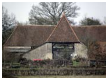
Ferme remarquable .Aunay-en-Bazois
