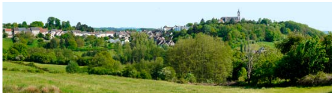
Plusieurs villages sont installés en hauteur, sur des éperons aux formes collinaires ou sur des cols dominant les vallées. Lormes
