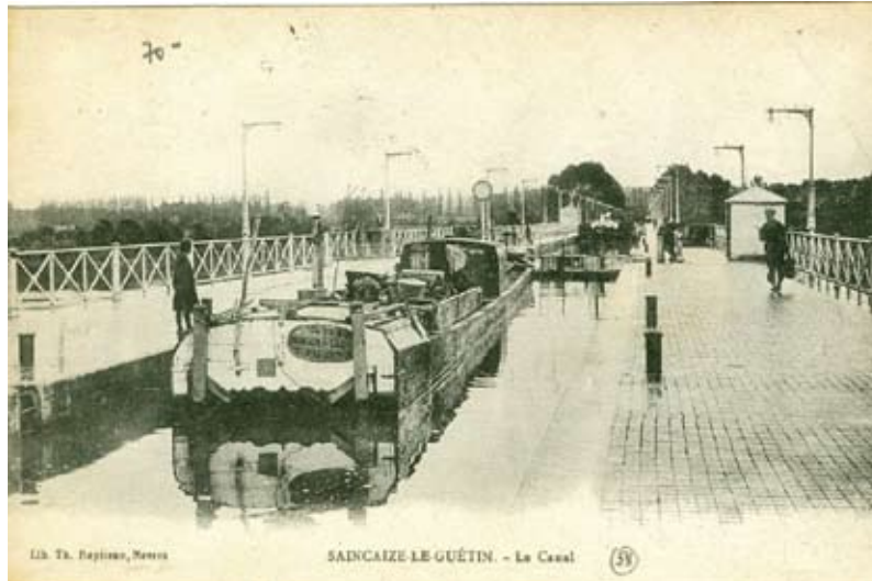
Au début du XXème siècle : le pont canal présente une grande qualité dans son traitement architectural et son mobilier
