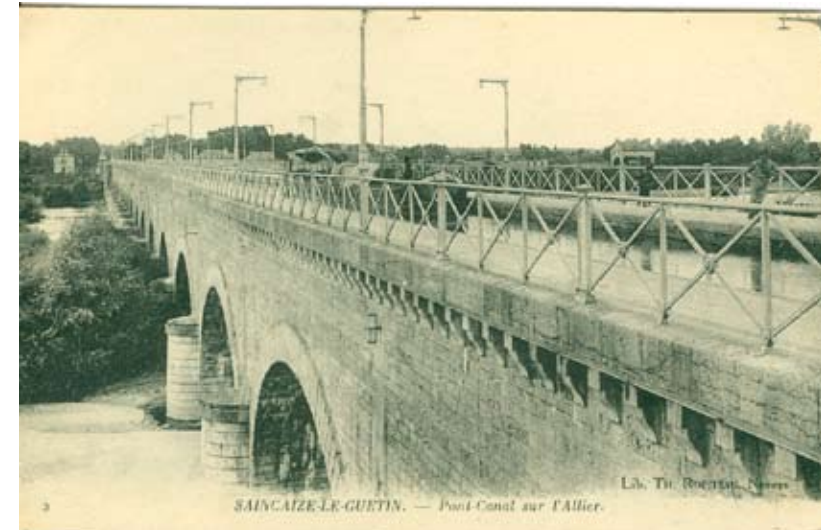
Au début du XXème siècle : le pont canal se perçoit dans son ensemble, révélant ainsi l'ampleur de l'ouvrage
