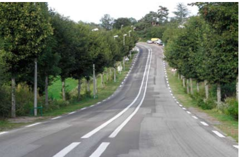
En 2010 : l'alignement arrive à maturité mais son effet est atténué par l'entretien insuffisant de la végétation située en arrière. Le paysage semble se refermer.
