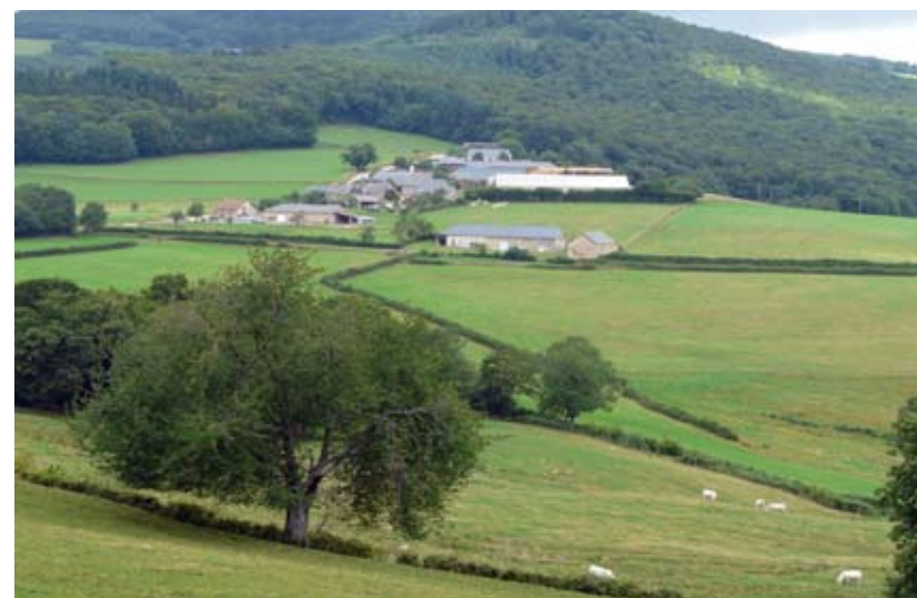
En 2010 : un nouveau bâtiment rompt l'harmonie par sa couleur trop claire qui souligne sa présence et l'importance de son volume
