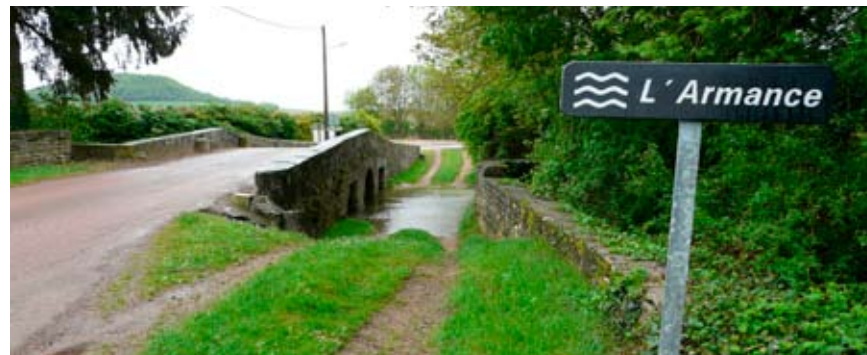
Mettre en valeur la perspective de l'axe du pont. Mettre en valeur les vues sur la rivière depuis le pont... Valoriser les situations originales comme les passages à gué. Dornecy
