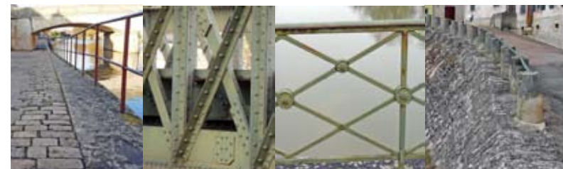
Aménager en respectant l'esprit et la qualité architecturale du canal. Utiliser des matériaux en accord avec l'identité architecturale du canal : fer et pierre.
