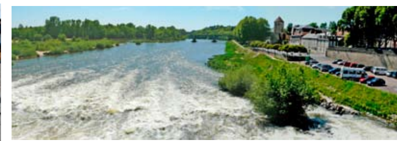
Gérer la végétation pour maintenir la covisibilité entre les deux rives de la Loire. Nevers
