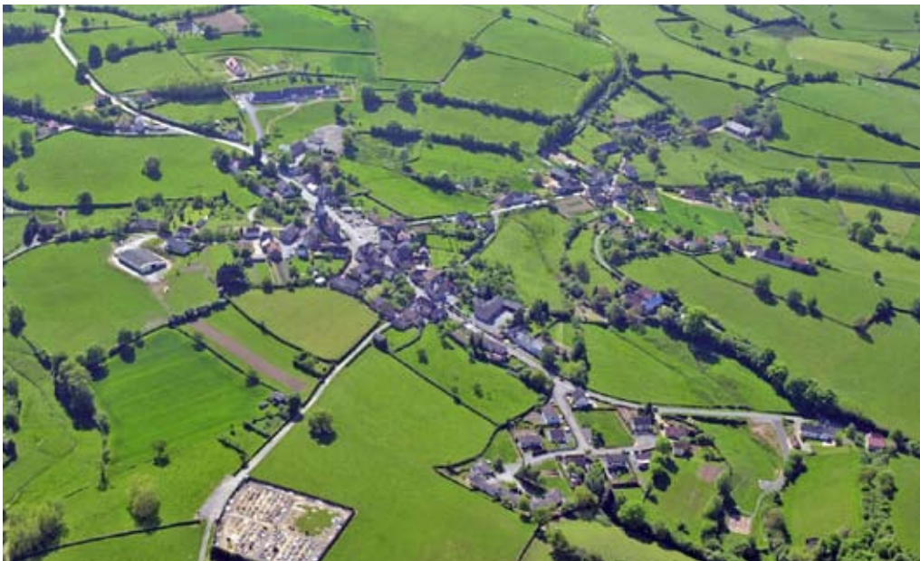
Préserver la silhouette groupée des villages. Maîtriser l'urbanisation linéaire et l'étalement urbain. Millay
