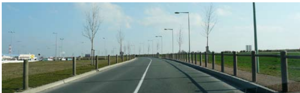
Créer un premier plan de qualité le long de la voie de contournement. Imposer un traitement des arrières de parcelles dans les zones d'activités. Cosne-Cours-sur-Loire
