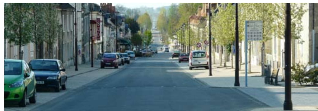
Aménager les traversées : l'ancienne RN7, requalifiée dans la traversée du bourg. Pougues-les-Eaux
