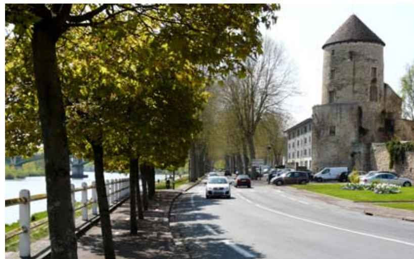
En 2010 : le trafic automobile s'est imposé dans l'aménagement. Voirie et stationnement occupent la majeure partie de l'espace entre la ville et le fleuve.
