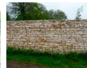
Mur de pierre calcaire. Menou
