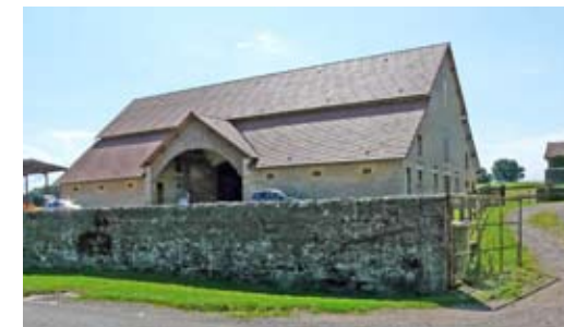
Imposants bâtiments de la ferme du Domaine St-Etienne dans le Bazois. Vandenesse
