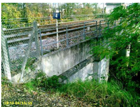
Figure 4 : culée du pont de la voie ferrée vue sur sa face aval
