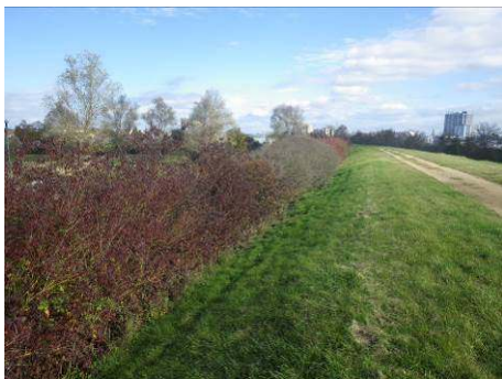
Figure 2 : digue vue vers l'amont avec végétation arbustive en milieu de talus coté val
