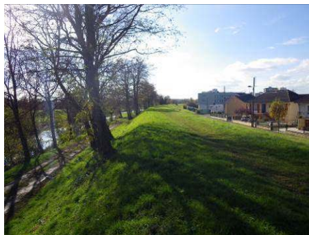
Figure 7 : végétation clairsemée sur talus coté canal vue vers l'aval
